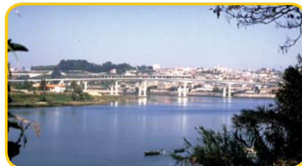
Fotografia 10 – Ponte do Freixo (fotografia de Adão da Fonseca)
