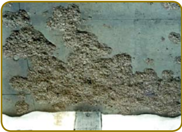
Figura 10 – Parte inferior da laje do primeiro andar onde não ocorreu destacamento
