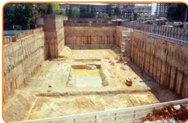
Figura 5 - Vista da escavação e contenção com uso de parede diafragma atirantada
