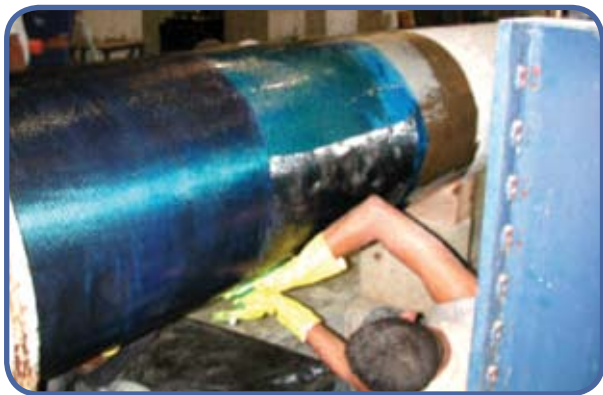
Figura 10 – Aplicação da fibra de carbono em um dos módulos ensaiados em laboratório
