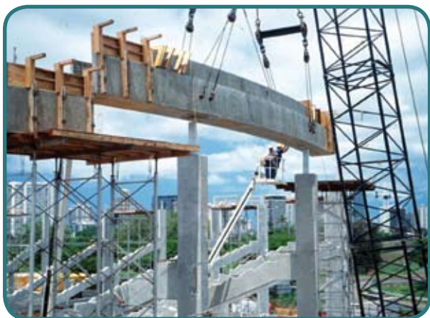
Detalhe do processo construtivo
