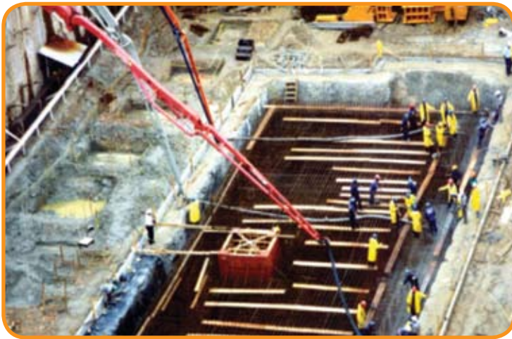
Figura 6 – Concretagem da sapata gigante
