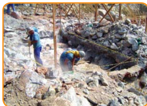
Foto 6 – Preparação da sapata apoiada em rocha
