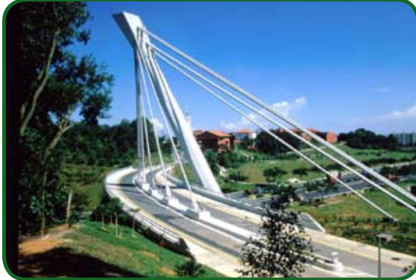
Viaduto Centenario Bridge, Espanha Ano da construção: 1991 Vão principal: 264 m Comprimento total: 552 m Largura total: 22 m
