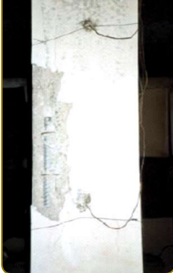
Figura 19 – Concreto superficial facilmente removível dos pilares do andar térreo, no entanto, sem a presença de destacamento natural
