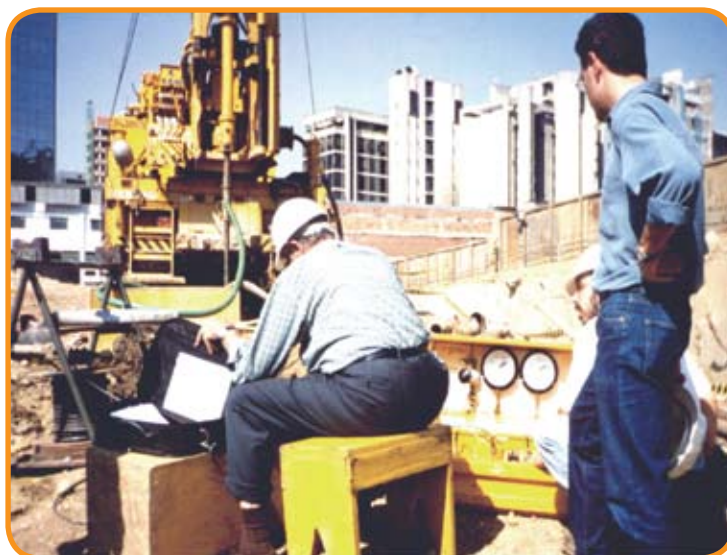
Figura 3 – Ensaio de pressiómetro de auto perfuração (Camkometer) realizado em parceria entre Engesolos, EPUSP e IPT
