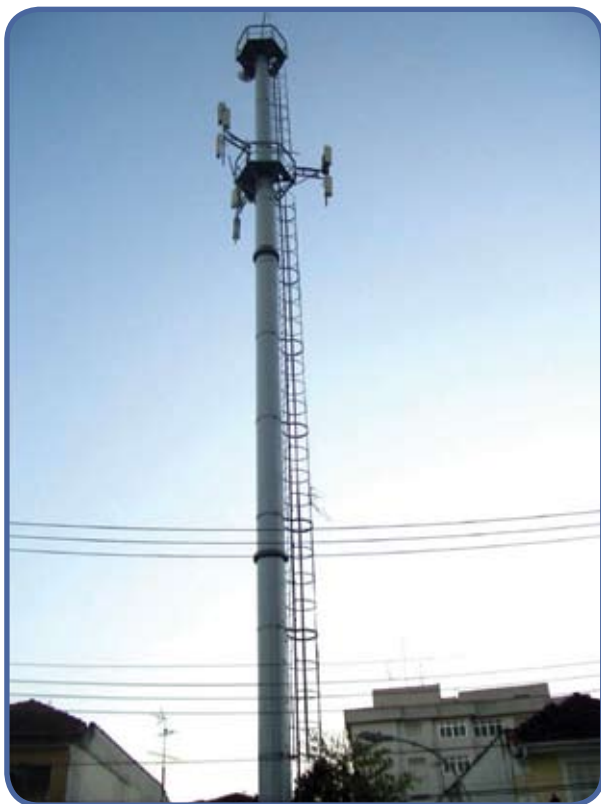
Figura 1 – Exemplo de um dos postes de concreto armado instalados.
