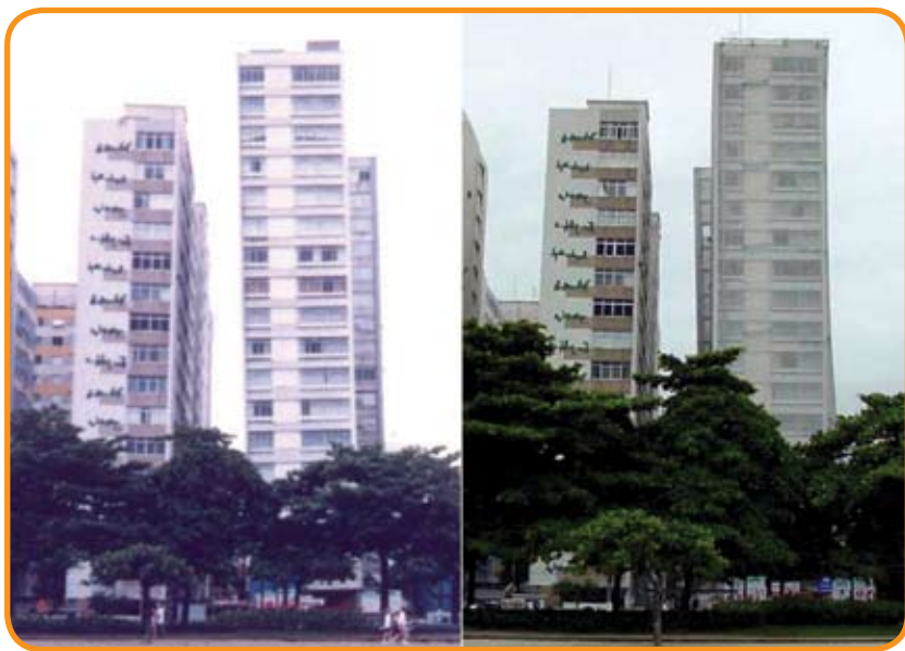
Figura 10 – Edifício Núncio Malzoni antes e após o reaprumo
