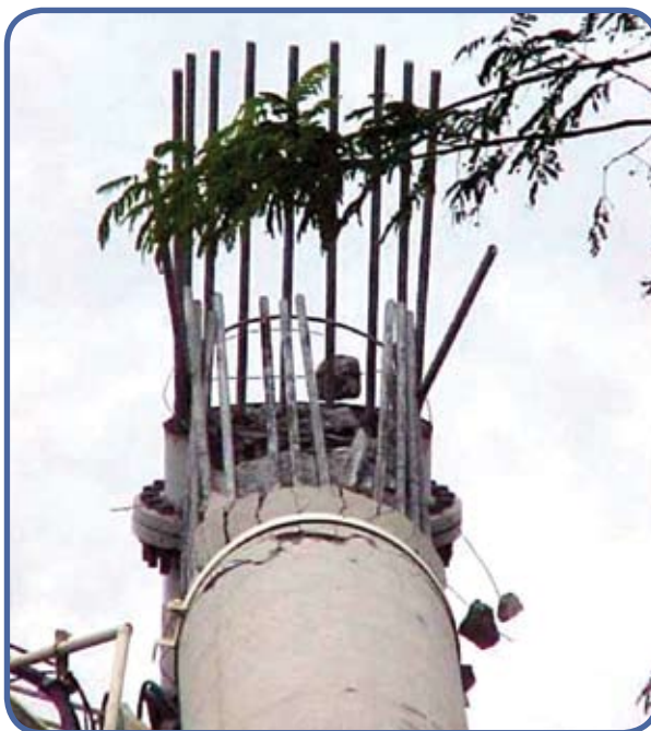
Figura 8 – Observar que as armaduras longitudinais da região de emenda por traspasse e que estão soldadas à flange permaneceram verticais indicando que o concreto rompeu sem as solicitar a flexão
