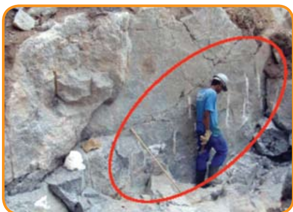
Foto 5 – Uso da Massa Expansiva, mais segura, boa para cortes verticais/planos, mas caras
