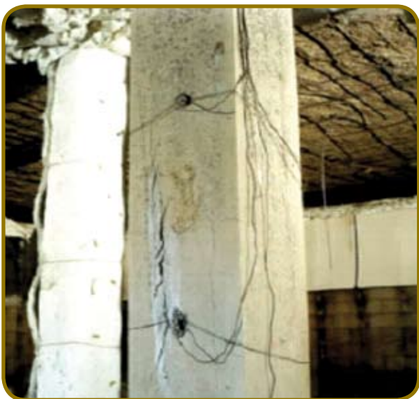
Figura 18 – Quadro de Fissuração no pilar do andar térreo
