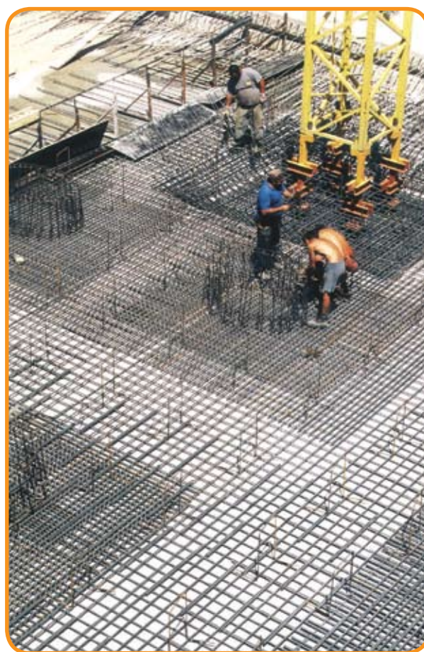
Execução de etapa da fundação
