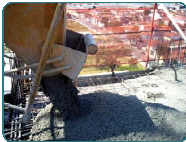
Concretagem da laje
