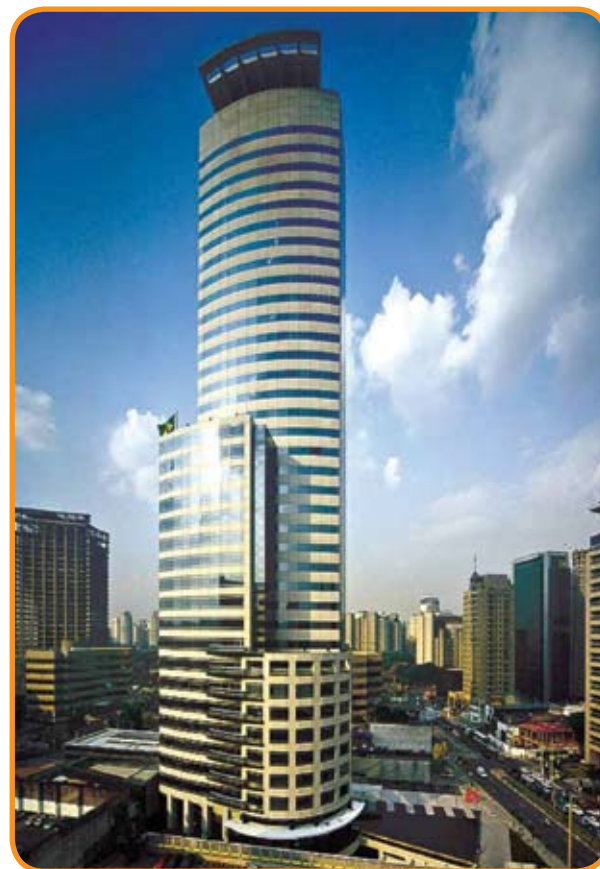
Figura 1 – Vista da fachada sul do E-Tower
