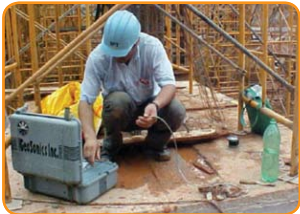
Foto 8 – IPT realizando as medições de vibração em um dos blocos nas proximidades da detonação
