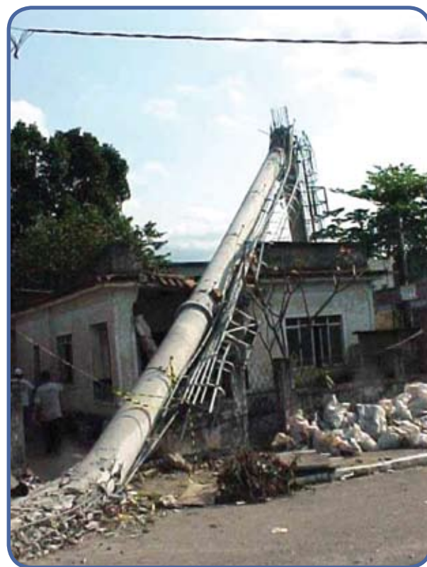
Figura 5 – Vista geral do colapso de poste de concreto armado
