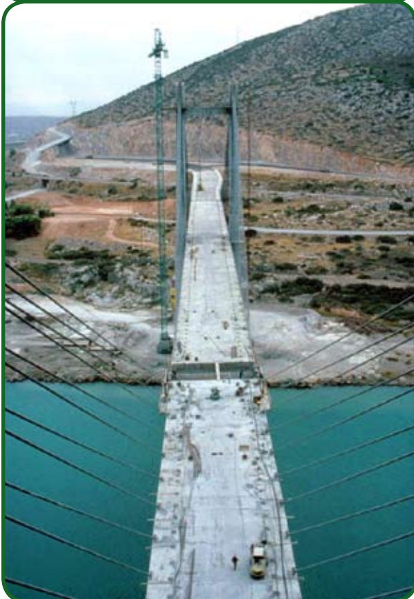
Ponte Evripos Bridge, Grécia Ano da construção: 1991 Vão principal: 215 m Comprimento total: 395 m Largura total: 14,1 m
