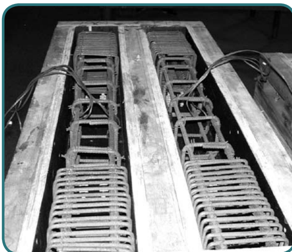
Figura 4 – Aspecto das armaduras e da fôrma dos pilares primários de seção quadrada
