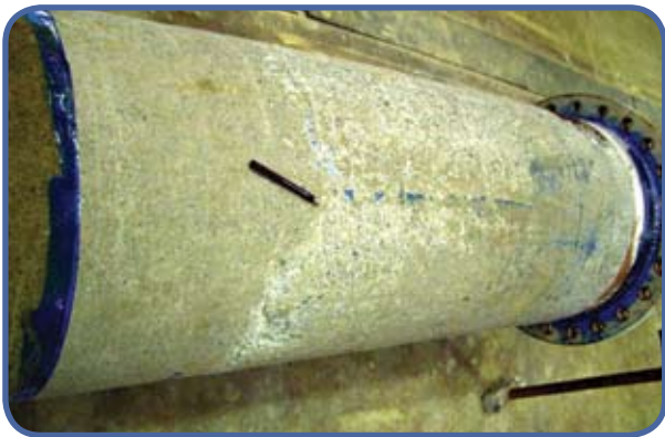
Figura 16 – Ruptura do primeiro ensaio com a emenda por traspasse reforçada, depois de retirada da manta de fibra de carbono da região do confinamento, não mostrando deterioração da região do traspasse
