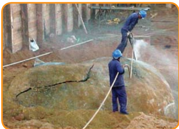
Foto 3 – Uso do martetele para furos, pequenos desmontes e acertos de sapatas
