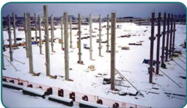
Construção em pleno inverno
