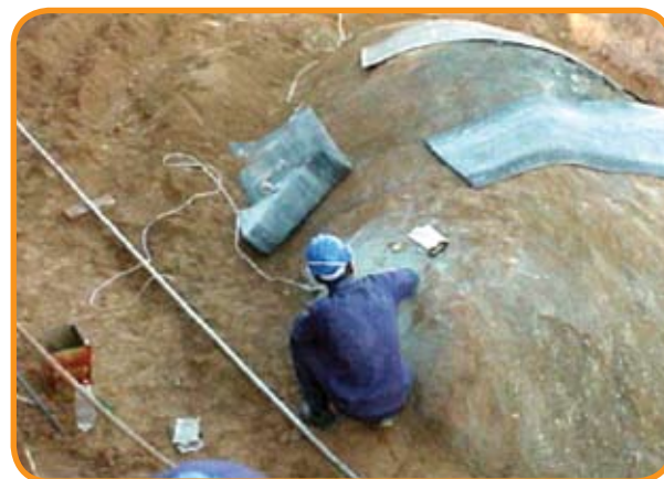
Foto 4 – Uso da pólvora (“Fogacho”) para desmonte de blocos maiores
