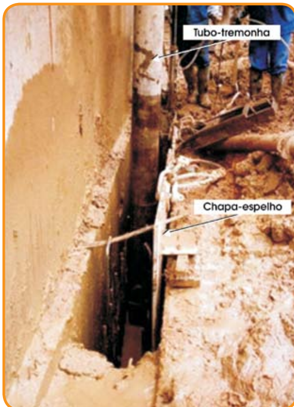
Foto 1 – Painel pronto para ser concretado. Verifica-se a chapa-espelho e o tubo-tremonha.
