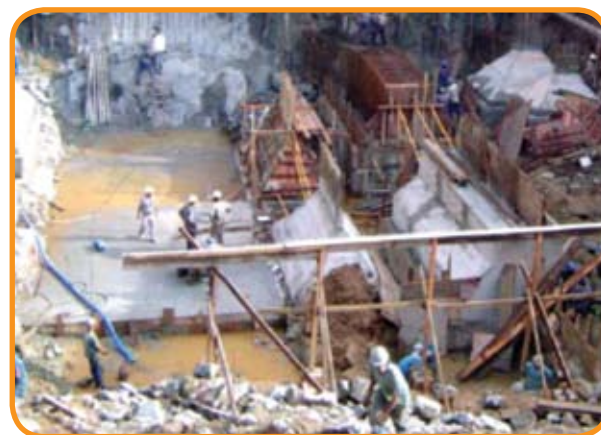
Foto 7 – Simultaneidade entre trabalhos de desmonte e de concretagem
