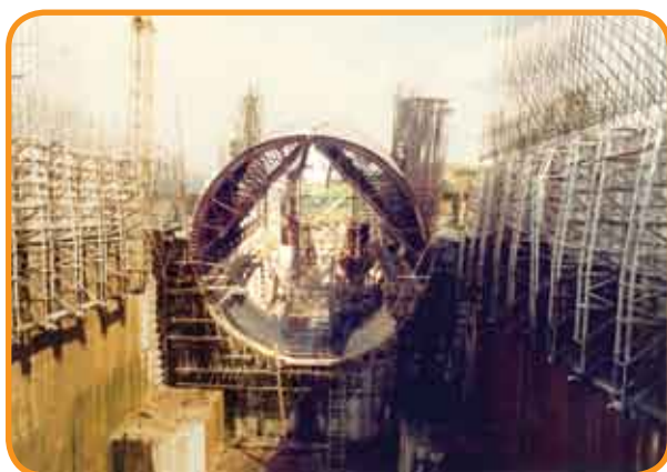
Figura 17 – Fôrma da transição da Tomada d'Água, da 1ª Etapa.
