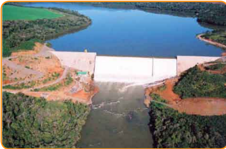
Barragem da UHE Santa Clara com o vertedouro em funcionamento
