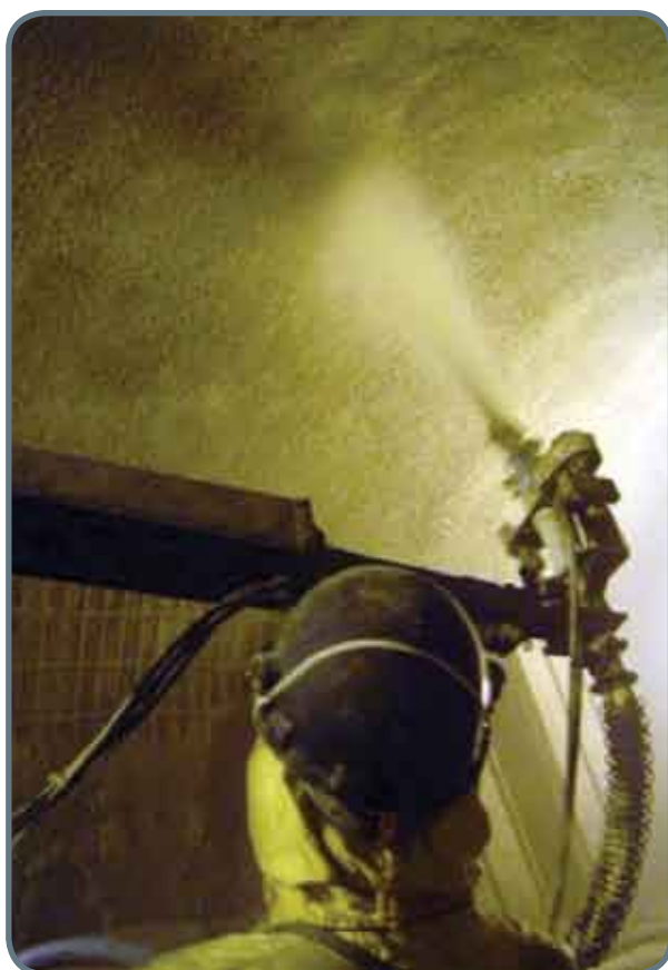
Figura 3 – Obtenção de resultados otimizados de aplicação através da utilização de robôs de projeção.
