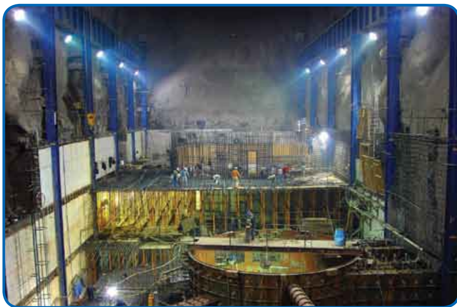
El Cajón, usina subterrânea, 700 MW, em construção.
