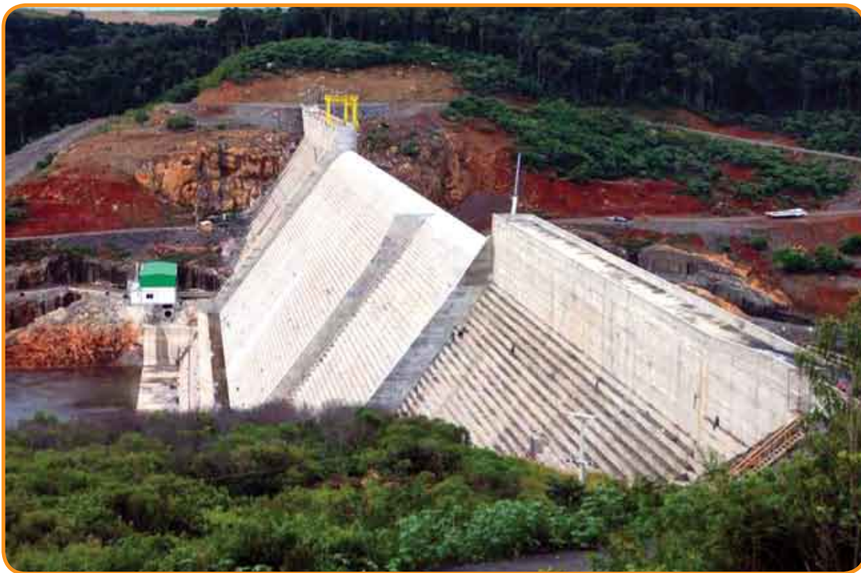
Vista da Estrutura do Vertedouro e Muros de Encontro em CCR – UHE Santa Clara
