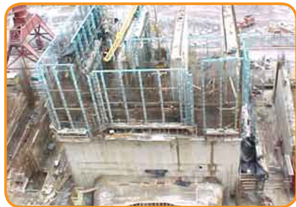
Figura 20 – Vista geral de montante de um dos blocos da Casa de Força da 2ª Etapa, em que pode ser observada a região dos nichos sobre o tubo de sucção sendo executado com fôrma deslizante.
