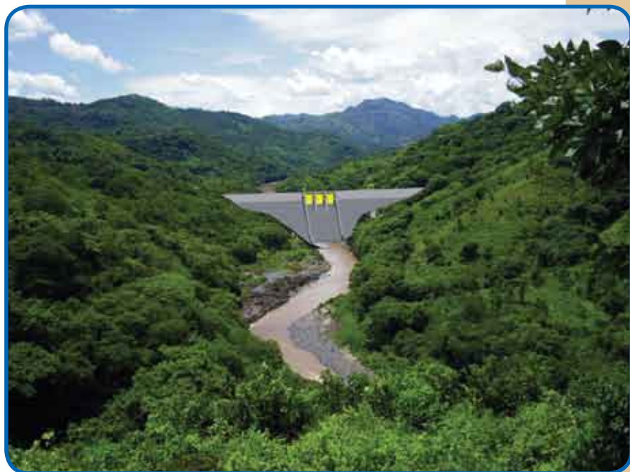
El Chaparral, barragem de CCR, usina externa, 67 MW, em fase de projeto básico.
