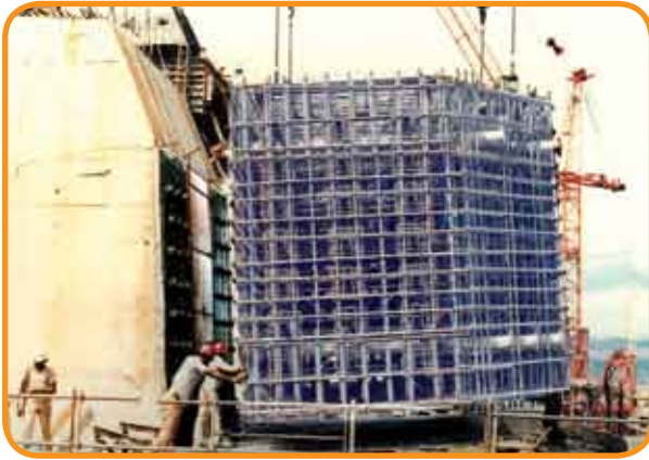
Figura 26 – Instante do lançamento da armadura da Viga do Munhão de um dos blocos do Vertedouro.
