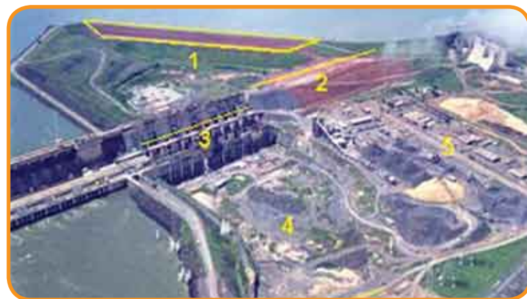
Figura 4 – Arranjo geral das obras da 2ª Etapa da Construção da Usina, em Maio de 2002, onde: 1 – Ensecadeira de Montante (região que foi removida); 2 – Barragem de Terra e Enrocamento; 3 – Barragem de Concreto – Unidades 13 a 23; 4 – Canal de Fuga II; 5 – Canteiro Industrial; e, 6 – Ensecadeira de Jusante (Septo Rochoso).
