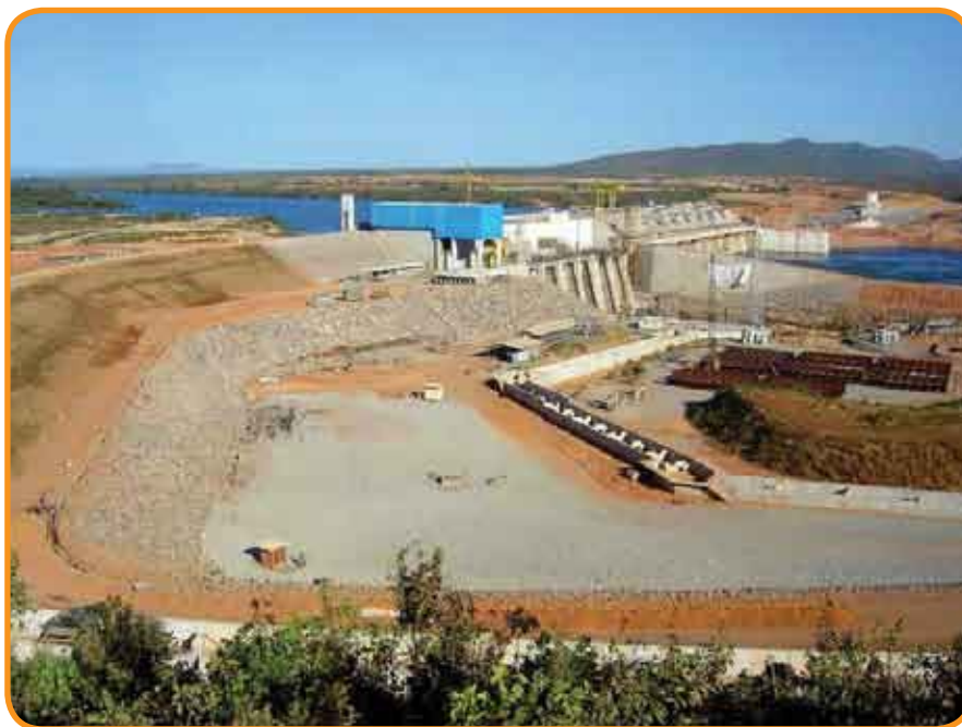
Detalhe da obra
