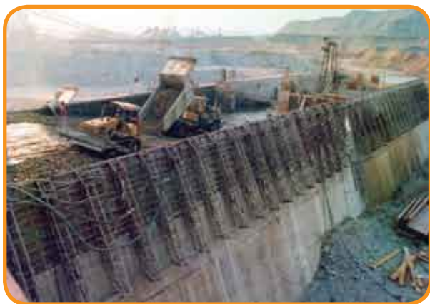
Figura 21 – Lançamento de concreto massa em rampa, com caminhão fora de estrada basculante e espalhamento com trator de esteira. Este tipo de lançamento chegou a alcançar a produtividade de 300 m 3 /hora.
