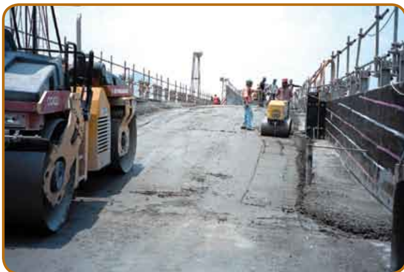
Figura 2 – UHE Lajeado – CCR rampado e compactação com rolos de grande (10t) e pequeno (1t) portes.
