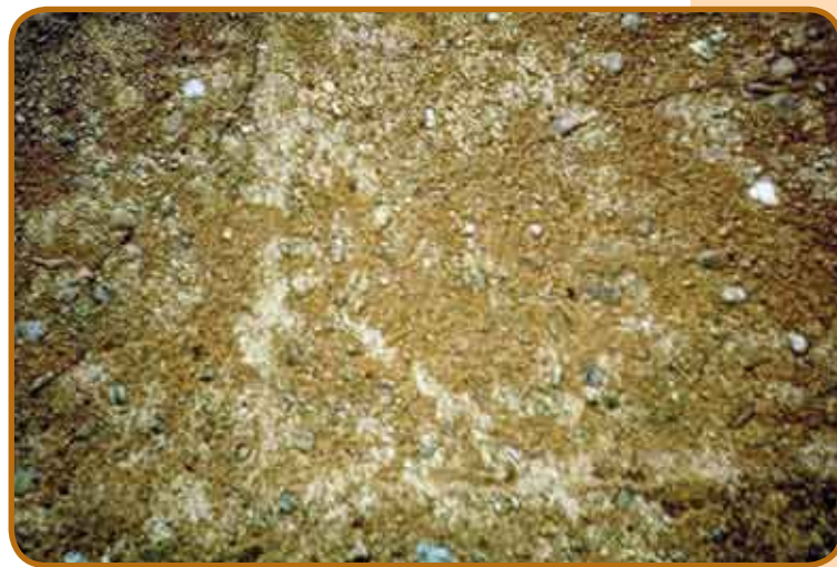
Erosão em superfície hidráulica pela ação de partículas sólidas
