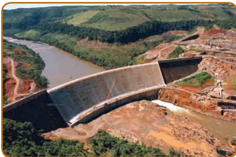
Vista aérea da Barragem do rio Jordão, construída com CCR.
