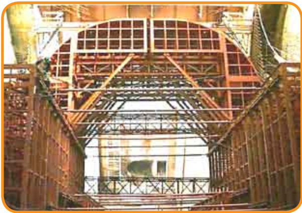
Figura 18 – Fôrma da transição da Tomada d'Água, da 2ª Etapa.
