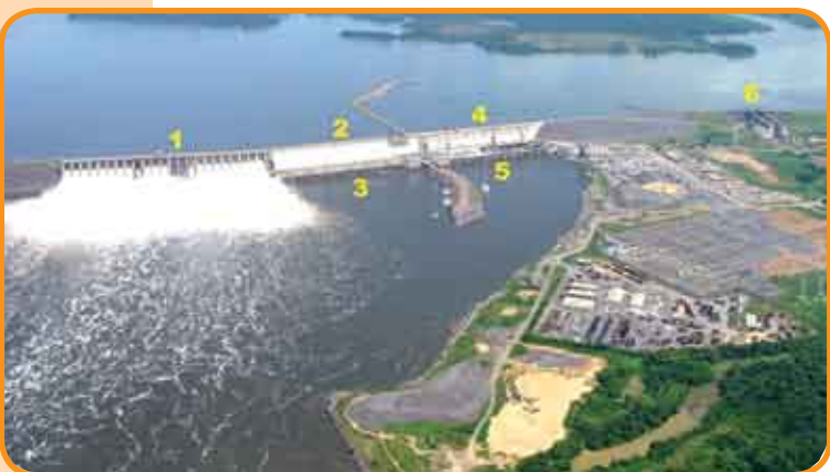
Figura 1 – Vista aérea de jusante da barragem de Tucuruí, onde podem ser vistos: 1 – Vertedouro; 2 – Tomada d'Água da 1ª Etapa; 3 – Casa de Força da 1ª Etapa; 4 – Tomada d'Água da 2ª Etapa; 5 – Casa de Força da 2ª Etapa; e, 6 – Eclusa 1.
