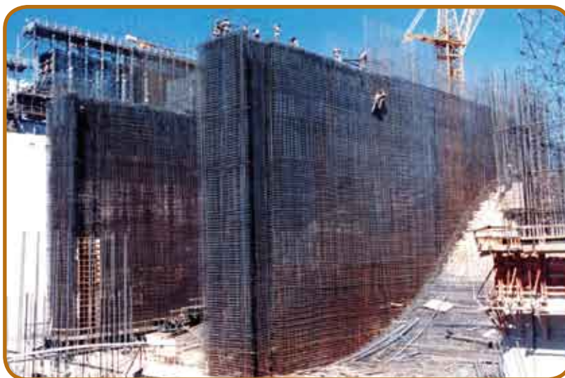
Pilar armado do vertedouro da Usina Hidrelétrica Lajeado, durante a construção.
