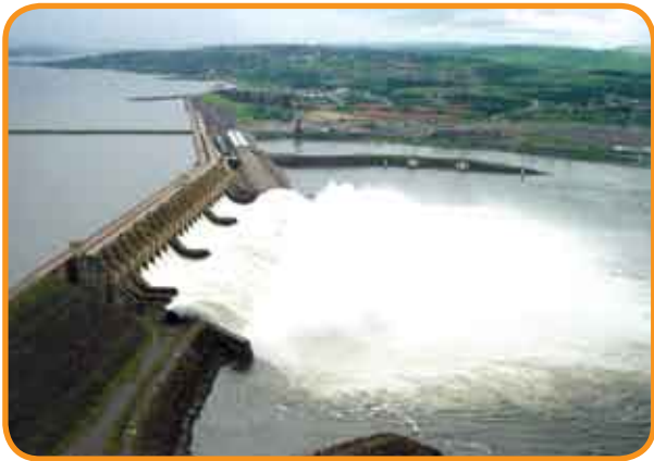
Figura 24 – Vista aérea do Vertedouro pela jusante direita.
