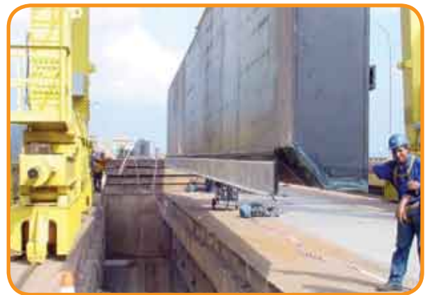
Figura 28 – Instante de posicionamento de uma das Vigas de Vedação no Vertedouro.
