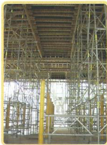
Início da montagem das torres de reescoramento.
