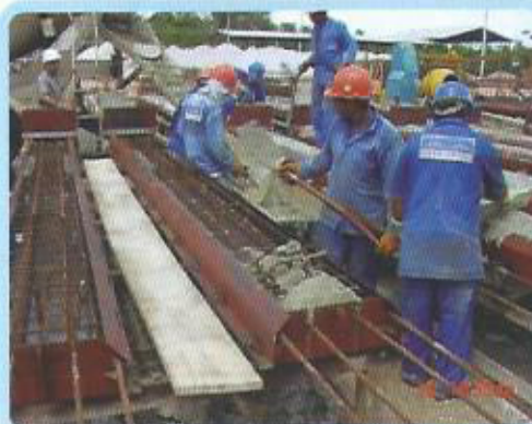
Foto 7 - Concretagem das pré-lajes
