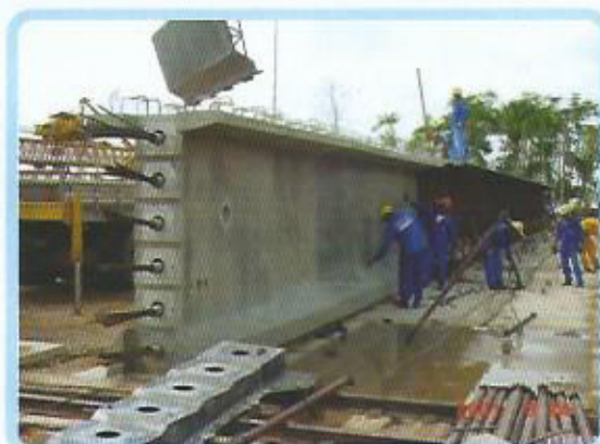
Foto 4 - Desforma das vigas.
