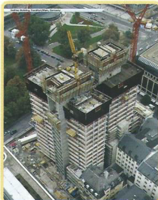
Paredes executadas com fôrmas sobre plataformas auto-trepantes. Prédio Galileu na Alemanha.
