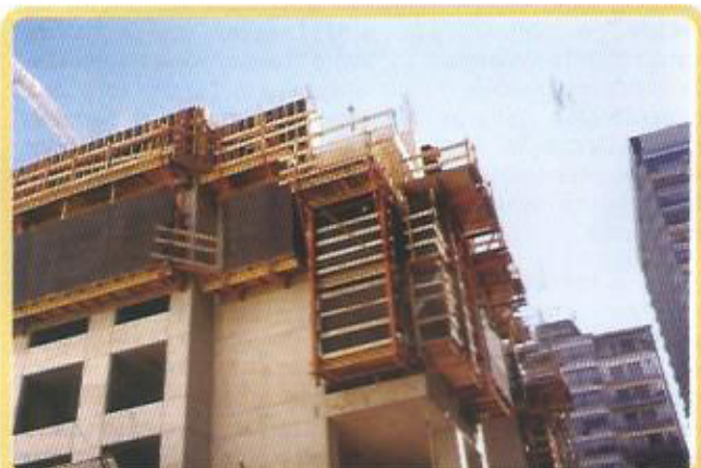
Fachada de concreto aparente executado com painéis pré-armados sobre plataformas trepantes.
