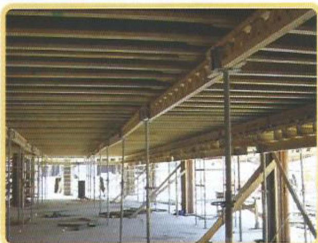
Estágio na montagem do escoramento com o sistema tradicional
