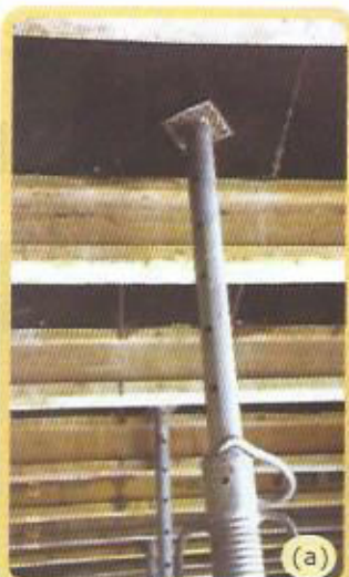
Figura 9 – (a) escoramento remanescente com escoras pontuais, posicionadas antes do início da desforma e (b) aspecto depois de desformado. Neste sistema as escoras remanescentes não são as mesmas que foram empregadas no cimbramento.
