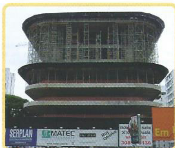
Escoramento com torres de carga numa obra na Av. Paulista
