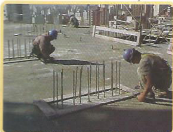
Figura 8 – Durante a marcação dos gualhos nenhum painel deve subir para a laje – Diretriz constante do Procedimento de Execução.
