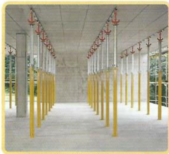
Reescoramento de uma laje executada com painéis modulares.
