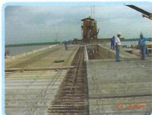
Foto 7 - Concretagem das pré-lajes
