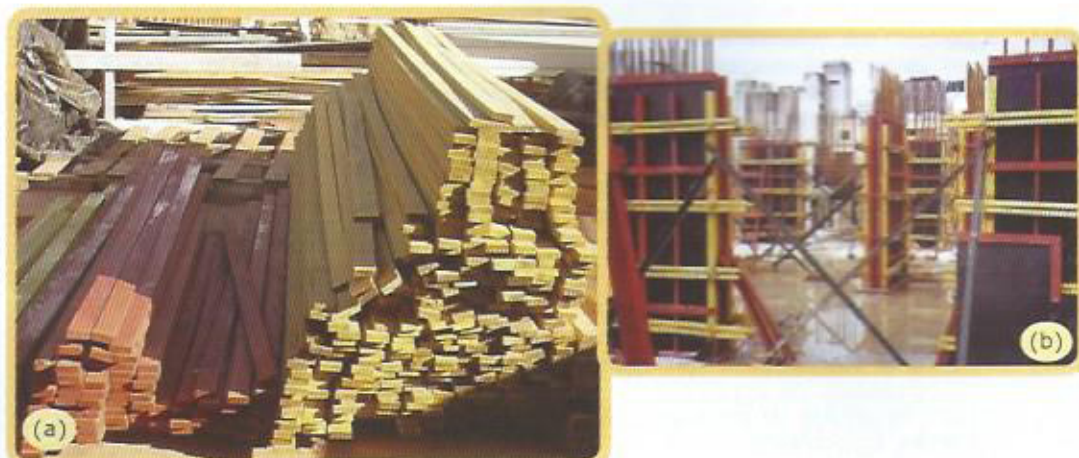
Figura 6 – (a) madeira serrada (sarrafos) pintada na central e (b) fôrma de pilares com componentes pintados, destacando-se o aspecto de equipamento resultante desta pintura.
