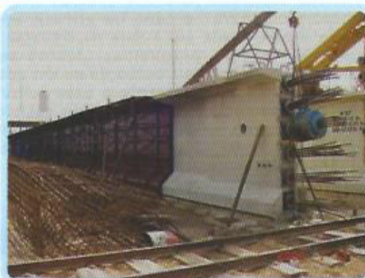
Foto 3 - Desforma e protensão das vigas.
