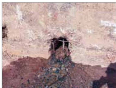
► Figura 4 Armaduras expostas na parede de concreto – local “A”
