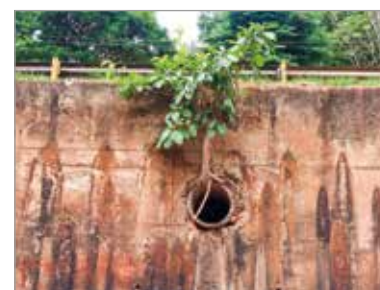
► Figura 5 Presença de vegetação na parede do canal, entre estacas 15 e 16
