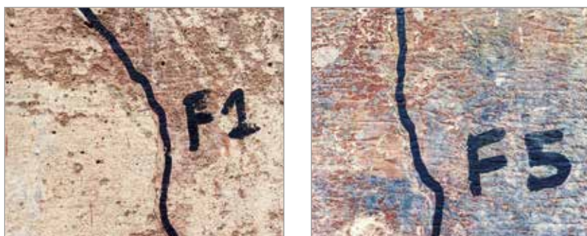
► Figura 7 Fissuras F1 e F5 observadas na parede do canal - local "A"
