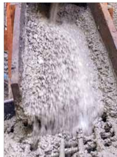
► Figura 6 Tubulação inadequada. Ocorrência de concreto segregado na saída da tubulação
