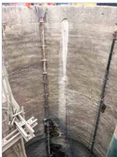
► Figura 5 Tubulação para transporte vertical sem curvas ou dispositivos dissipadores de energia. Alternativa inadequada
