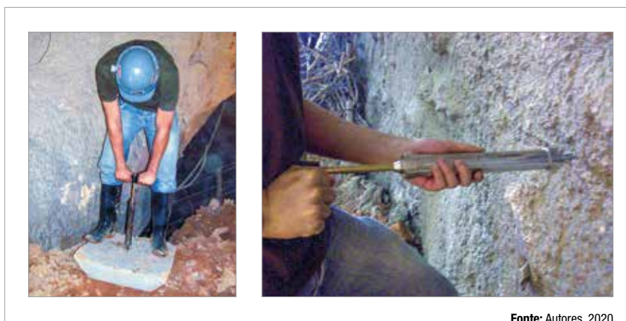
► Figura 12 Execução de ensaio com Agulha de Meynadier – na placa moldada para controle de resistência e na própria estrutura projetada na parede do túnel
