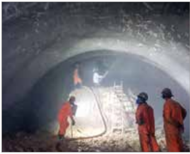
► Figura 1 Exemplo de concreto sendo projetado, via úmida, para revestimento primário de túnel escavado pelo sistema NATM
