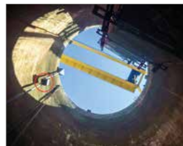
► Figura 7 Inserção de caixas retentoras ao longo da tubulação para diminuir a velocidade de queda do concreto
