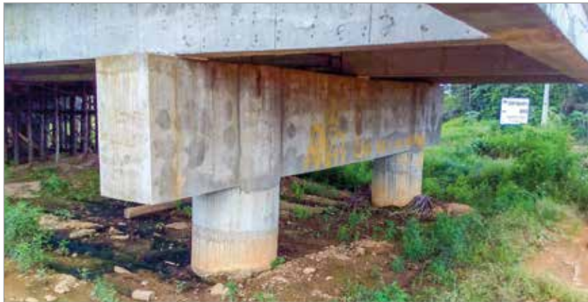
► Figura 6 Detalhe do apoio da longarina sobre a transversina
