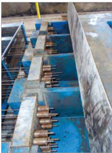
► Figura 8 Pontos de ancoragem dos fios protendidos
