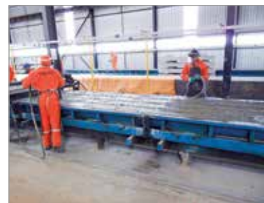
► Figura 9 Vibração e acabamento no concreto, Lote 2S, Ferrovia Norte-Sul
