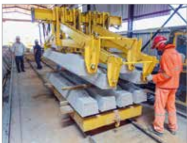
► Figura 10 Manuseio de dormentes com auxílio de equipamento específico, Lote 2S
