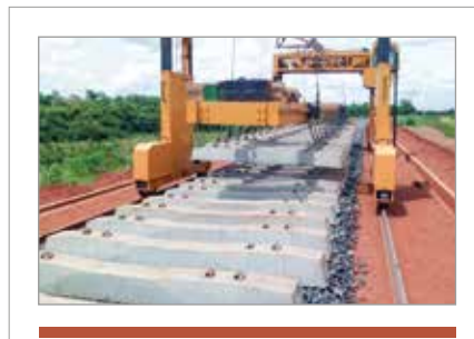
► Figura 1 Registro do momento de aplicação de dormente na via com auxílio de pórtico rolante, Ferrovia Norte-Sul, Lote 5S, Minas Gerais
