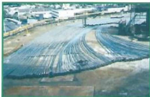
Foto 4: pré-montagem de cabos engraxados
