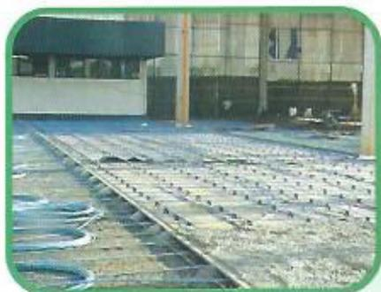
Fig. 6: Detalhe construtivo das cordoalhas posicionadas na pista
