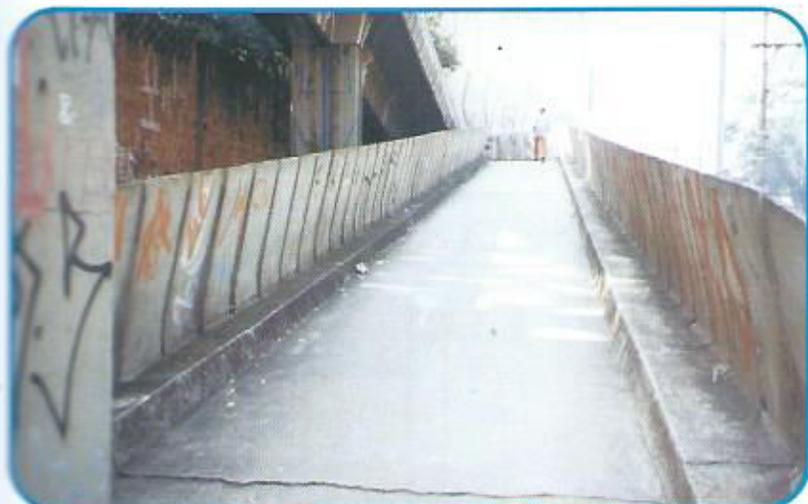
Figura 3. Caso de desniveles con pendiente inadecuada y causando problemas de acumulación de humedad y degradación del concreto.
