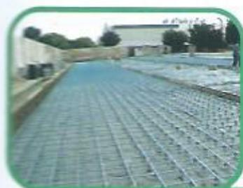
Fig. 10 e 11: Vista geral do posicionamento das cordoalhas e etapa de concretagem utilizando régua vibratória
