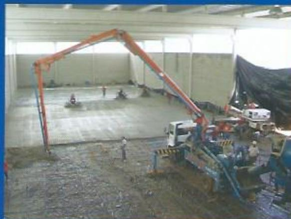
Foi dimensionado piso com 13cm de espessura, com cordoalhas para protensão engraxadas e plastificadas, nas duas direções, com 35 cordoalhas longitudinais e 90 cordoalhas transversais, centradas e tracionadas com 15 ton cada uma.
