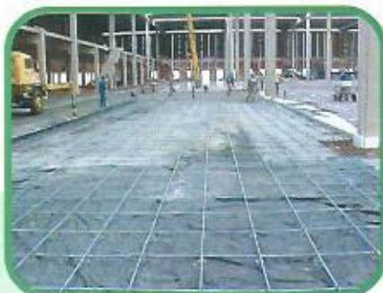
Fig. 7: Detalhe montagem das cordoalhas
