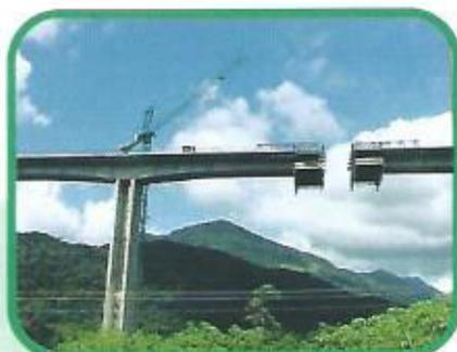
Trecho de balanço sucessivo em execução, do viaduto VD-07
