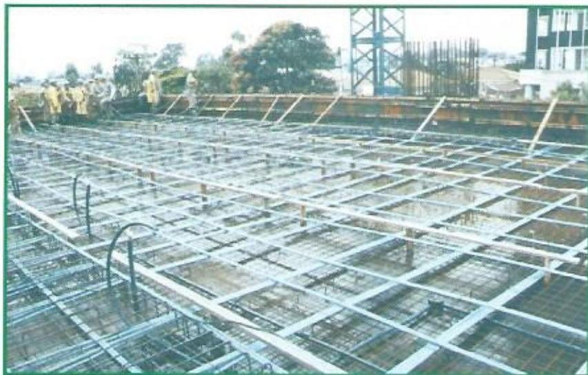
Foto 5: colocação dos cabos em obra
