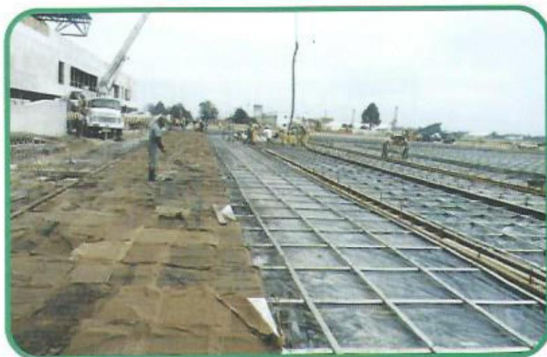
Fig. 4 - Faixa de concretagem de 3,40m e cura de faixa já concretada
