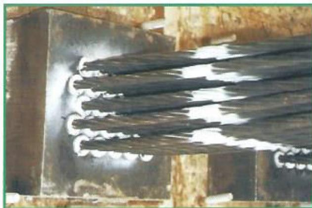
Foto 8: pintura de cordoalhas, para medição de alongamentos
