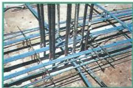
Distribuição de cabos em camadas, com cadeirinhas metálicas para suporte nas cotas
