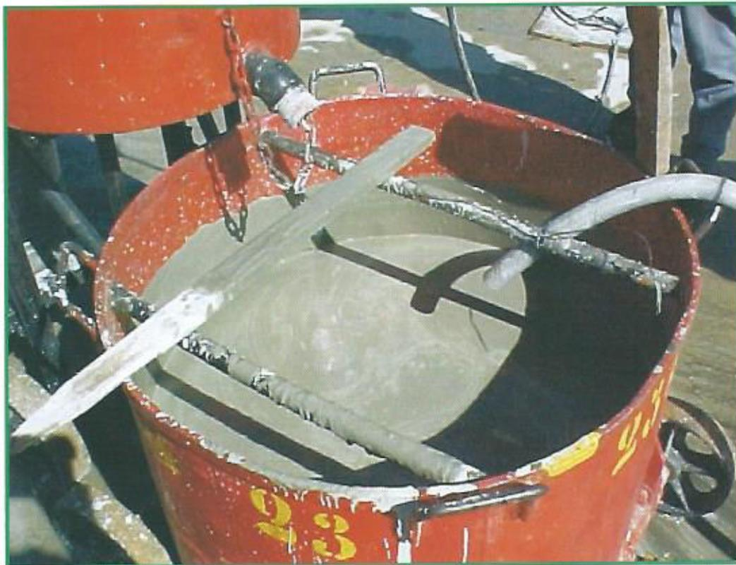
Foto 9: operação de injeção dos cabos
