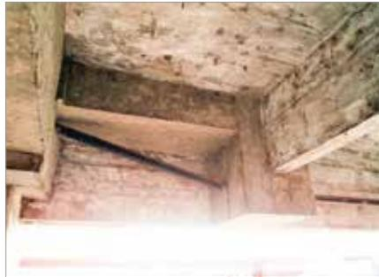
(c) Detalhe dos blocos e vigas na ancoragem
