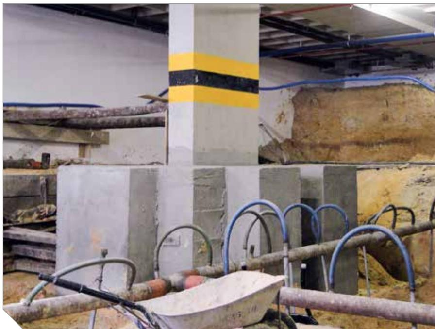
**Bloco de fundação reforçado, após seu envelopamento com concreto e pintura impermeabilizante**
