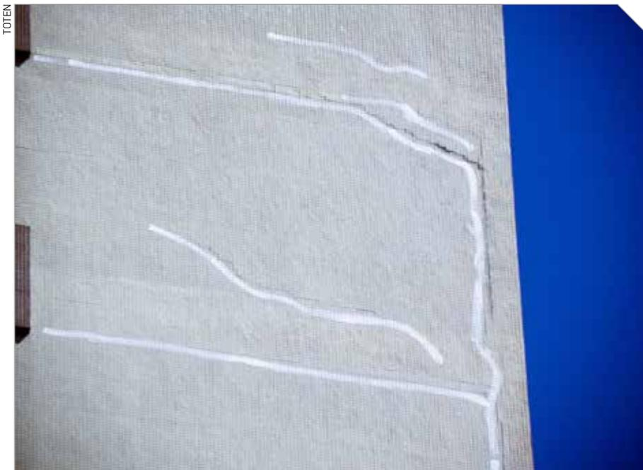
Fissuras típicas de falhas nas regiões de amarração das alvenarias aos pilares e às vigas
