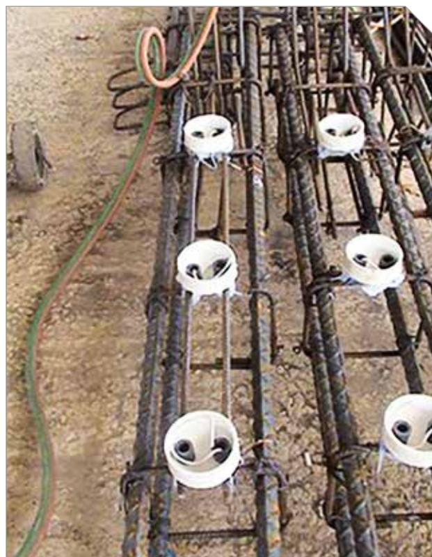
**Figura 5 – Columna con aditamentos insertados desde la construcción para poder medir humedad, temperatura, potencial y velocidad de corrosión**
