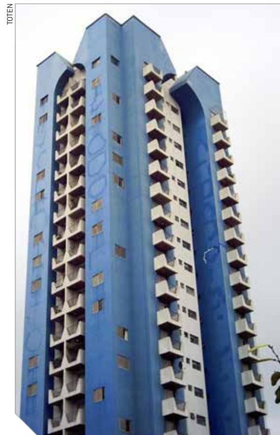
**As fissuras verticais ocorrem na região de amarração das alvenarias aos pilares e as horizontais, na região de fixação das alvenarias às vigas de periferia das fachadas**
