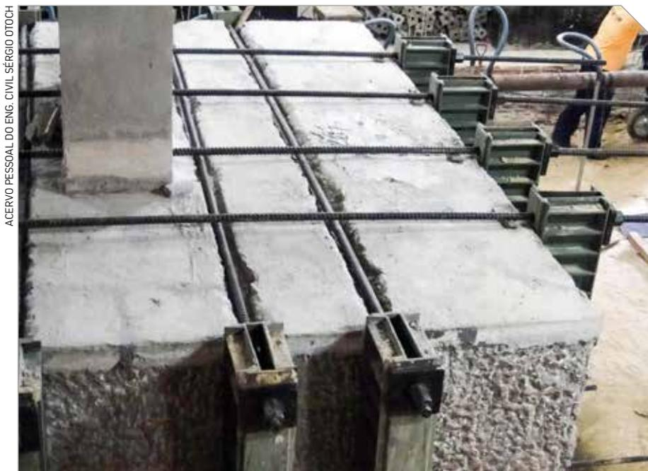
Detalhe das barras Dywidag para recuperação dos blocos de fundação afetados por RAA
