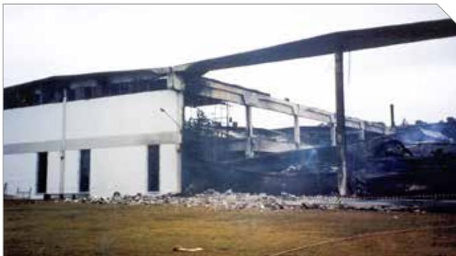
Foto 1 – Vista geral da ruína de estrutura de concreto pré-moldado, decorrente de incêndio, no edifício de tecelagem Zêlo
