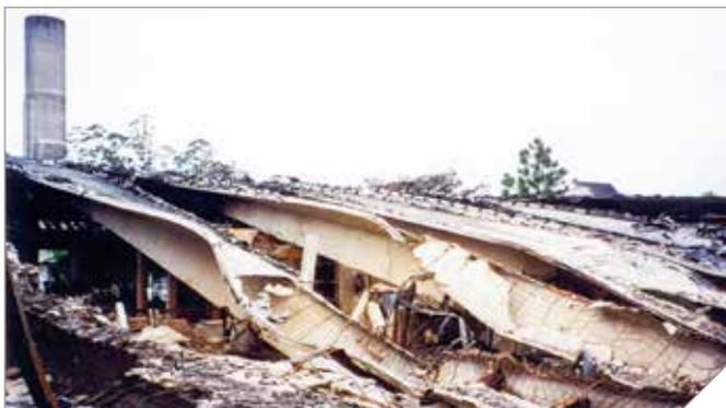
Foto 2 – Ruína da cobertura de concreto pré-moldado, decorrente de incêndio, no edifício de tecelagem Zêlo
