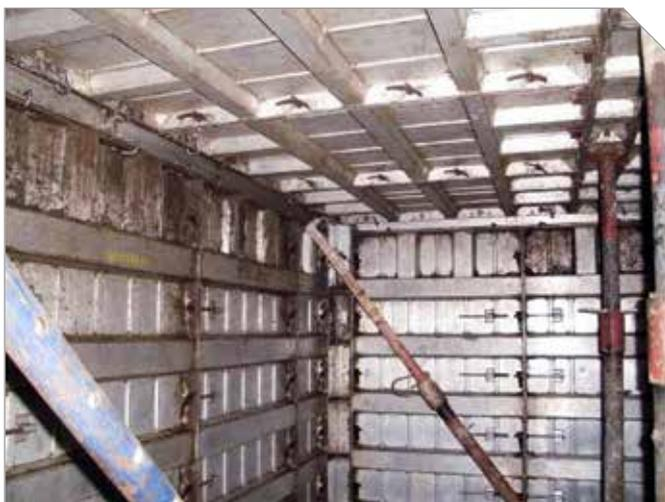
Foto I – Vista interna da fôrma de alumínio montada
