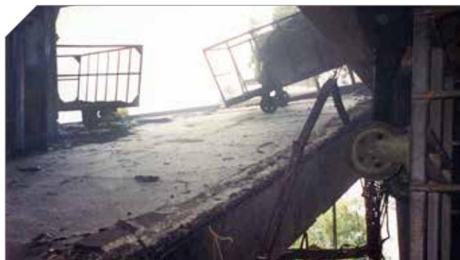
Foto 3 – Escorregamento de painel de laje em estrutura de concreto pré-moldado, decorrente de incêndio, no edifício de tecelagem Zêlo
