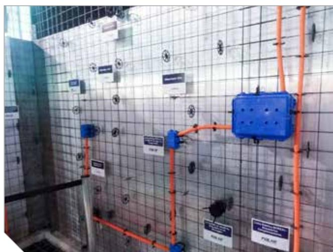
Foto 3 – Acessórios de plástico específicos para paredes de concreto
