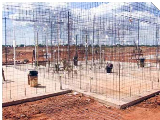
Foto 2 – Armações das paredes em telas montadas
