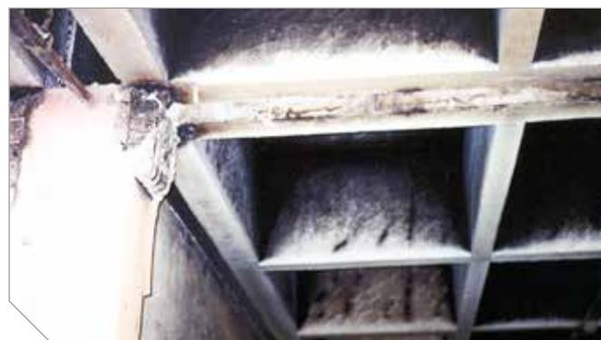
Foto 4 – Deformação de pilar e deslocamento de painel de laje, decorrentes de incêndio, no edifício de tecelagem Zêlo
