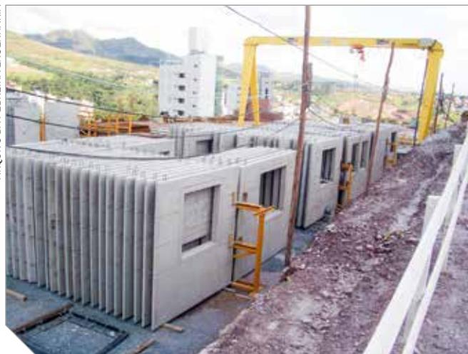
**Painéis Portantes Pré-Moldados estocados para serem usados na obra**
