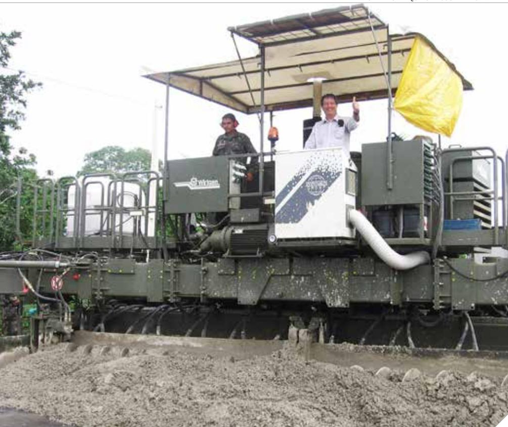
**Espalhamento e adensamento do concreto por pavimentadora pilotada pelo Prof. Balbo**
