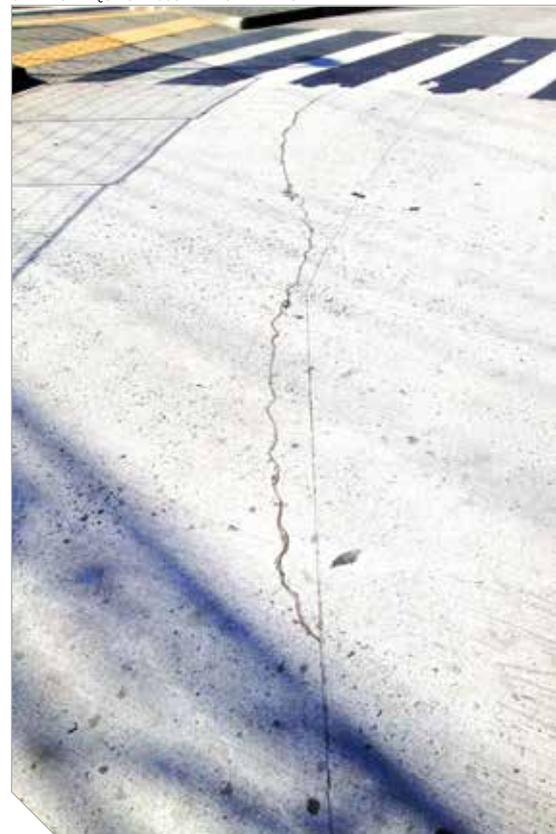
**Fissura de retração longitudinal em terminal de ônibus**
