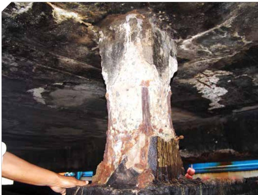
**Corrosão de armadura de um pilar, comprometendo sua durabilidade**
