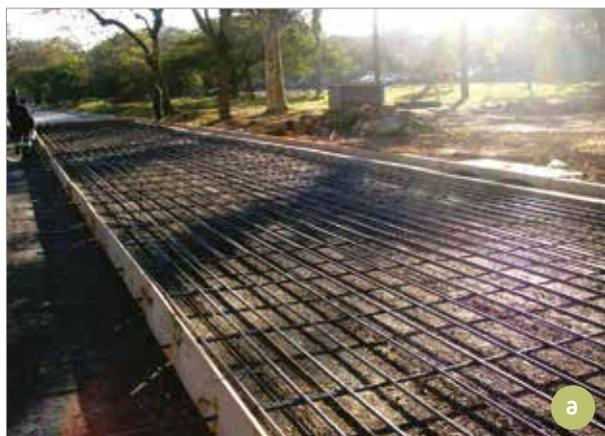
Armadura longitudinal (seção 1)
