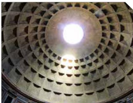
Foto 2 – Cúpula do Panteão, maior vão livre em concreto não armado
