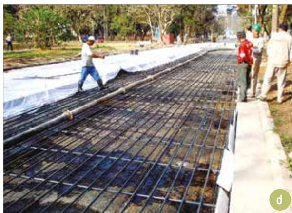
Armadura longitudinal (seção 4) e cura (Seções 1 e 2)
