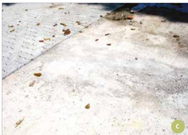
Junta entre a pista e o pavimento intertravado (seção 1)
