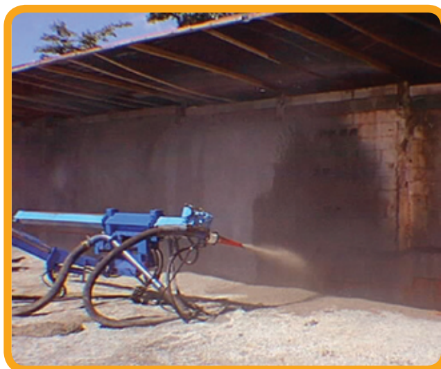
Aplicação de concreto projetado com fibras
