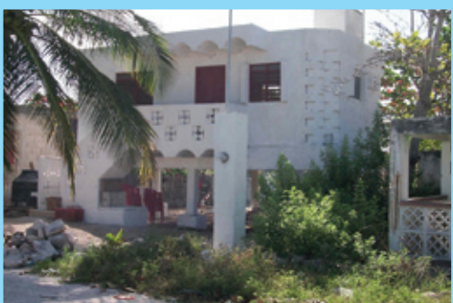
Figura 3 - Vivienda tipo Palafito de concreto terminada y con vida útil estimada de más de 50 años.
