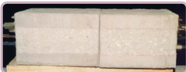
Figura 2 - Aspecto da superfície do concreto preparada e limpa.
