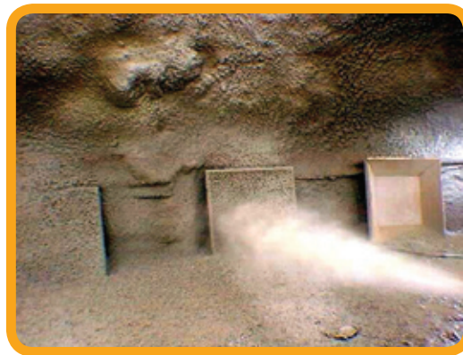
Moldagem de placas para ensaios em concreto projetado
