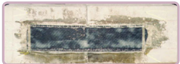
Figura 4 - Aplicação do compósito de fibras de carbono.
