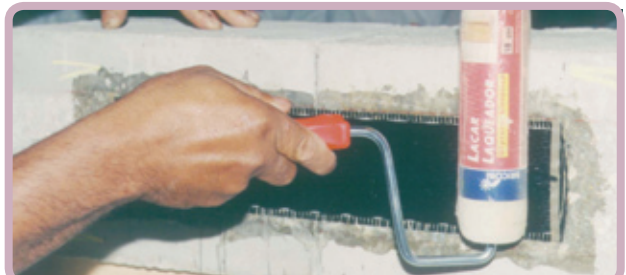
Figura 5 - Fixação do compósito de fibras de carbono.
