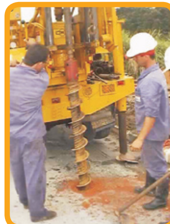
Perfuração com equipamento mecanizado de soldagem com emprego do trado vazado estanque (hollow stem auger)
