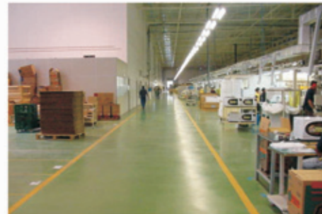
Piso cimentício - MASTERTOP 100
