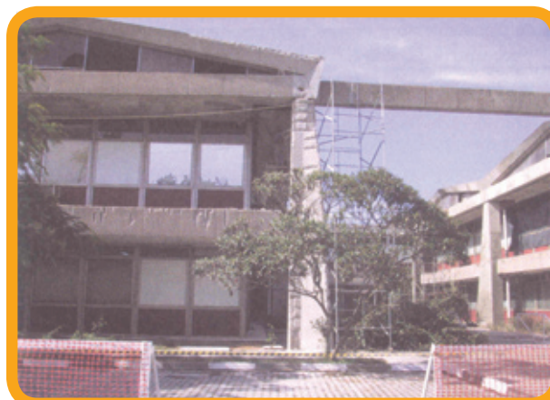
Reabilitação de estrutura de concreto corroído por carbonatação
