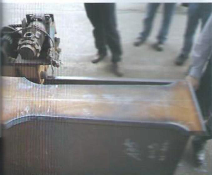
Corte "Dogbone" en una de las conexiones rígidas
