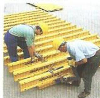
A escolha dos materiais a serem empregados para o escoramento (madeira ou equipamento metálico) também depende da análise de vários fatores como tipo de estrutura, cargas, alturas e tempo de execução. No entanto, o cimbramento metálico vem sendo bastante utilizado em todos os diferentes sistemas - tanto para fôrmas mais convencionais como para fôrmas industrializadas.
