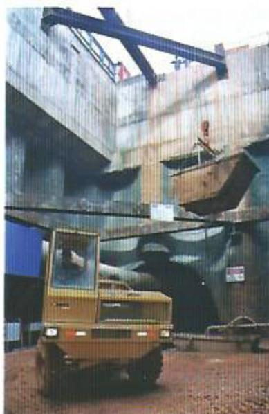
Sistema de remoção do maciço escavado no método NATM
