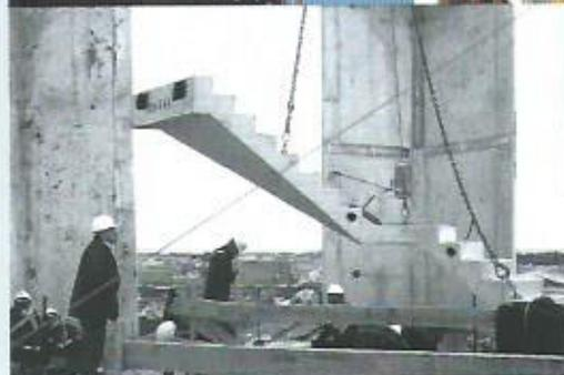
Acima plataforma pré-moldada sendo posicionada. Ao lado escadaria pré-moldada
