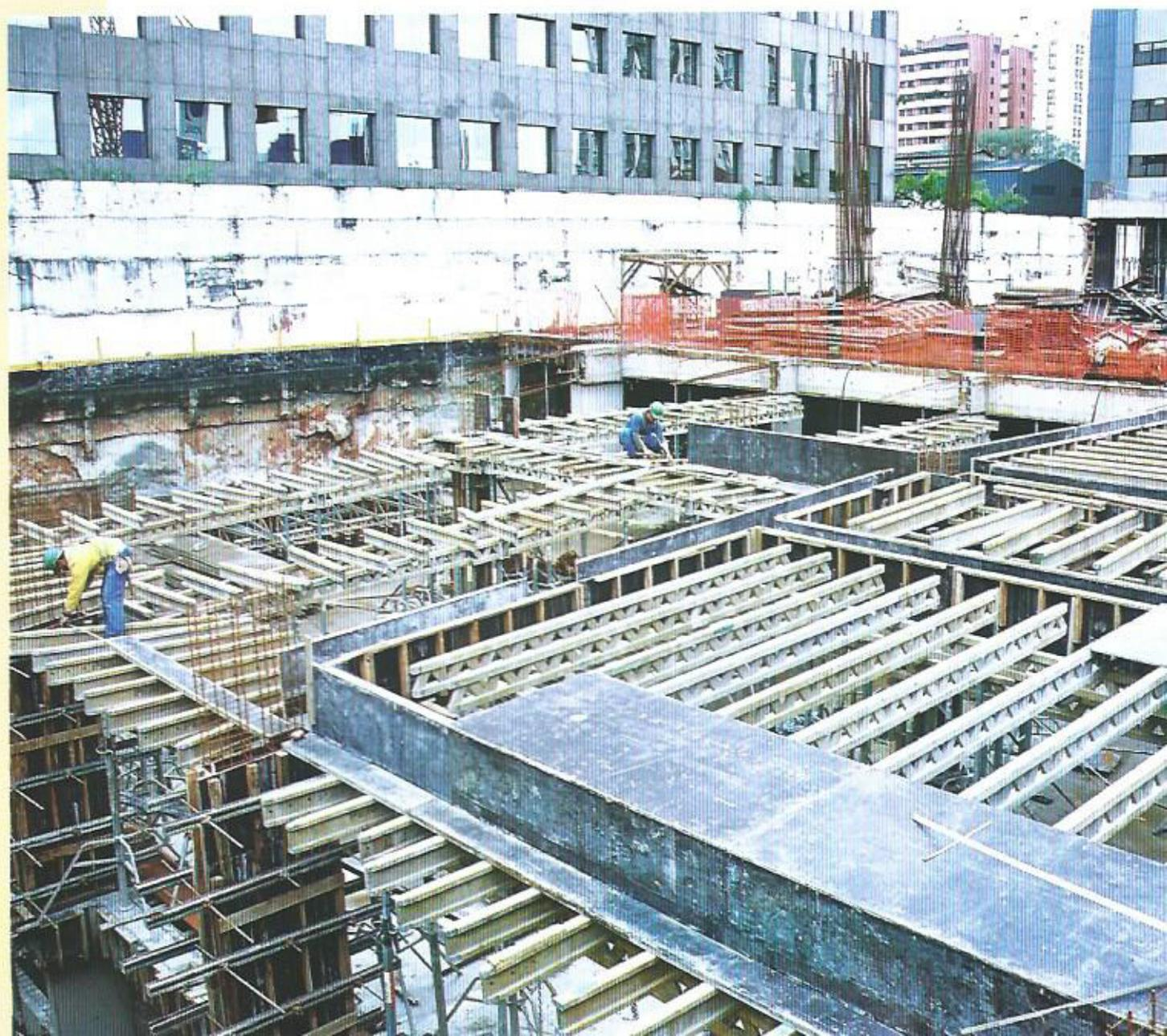
O concreto é moldável, por isso é preciso prever a montagem das fôrmas, planejar os travamentos, escoramentos e a desforma. Além disso, é preciso analisar com atenção o mercado nacional de fôrmas, que ao longo dos últimos 15 anos vem diversificando a oferta de soluções para construções de concreto.
