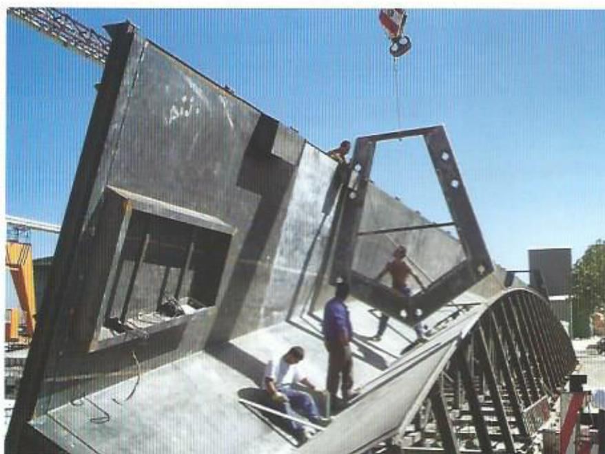
Acima montagem da cofragem para a coluna pré-moldada. Ao lado seções da coluna deitadas
