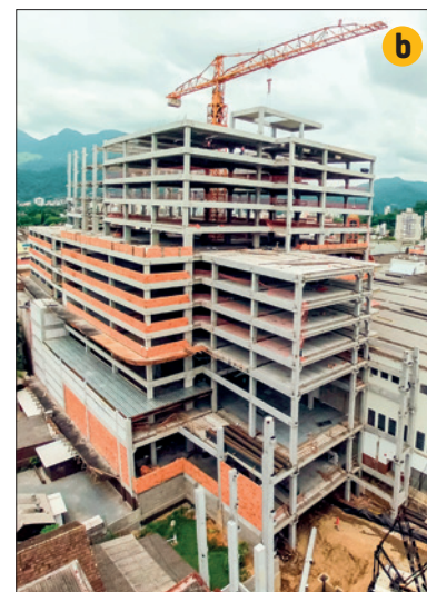
► Figura 1 Prédio com 65m, com estrutura integralmente pré-fabricada de concreto, em Jaraguá do Sul. Diferentes fases da montagem (a e b)
