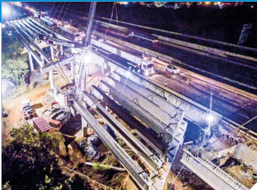
Foto 6 – Montagem noturna da Ponte Anhumas
