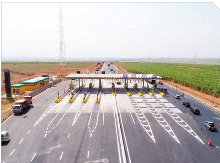
Foto 3 – Praças de pedágio pré-fabricadas de concreto adotadas pela Arteris/Viapaulista
