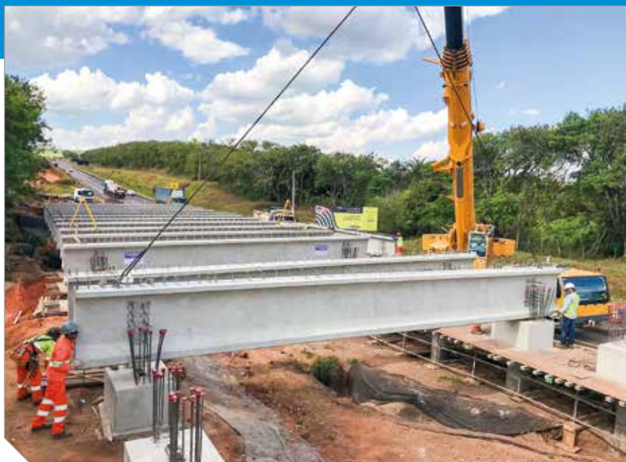
Foto 4 — Montagem de OAE na duplicação da Rodovia SP-147
