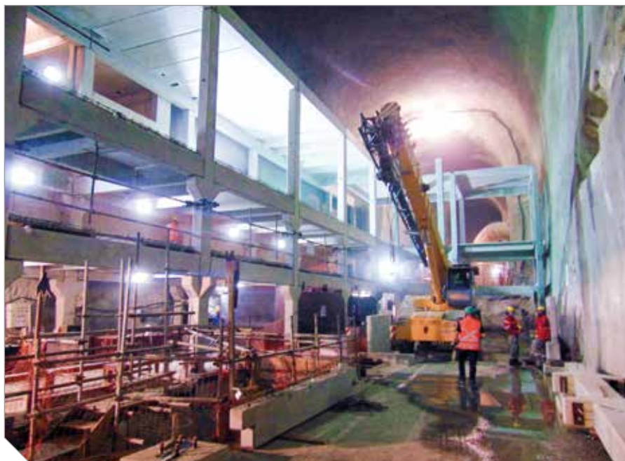
Foto 1 — Expansão da Estação General Osório Metrô RJ, em fase de montagem
