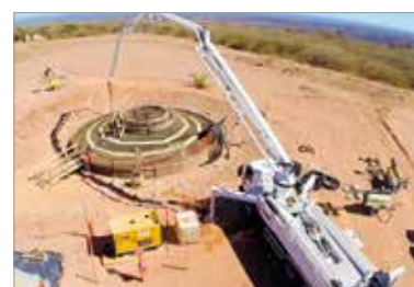
► Figura 3 Concretagem de uma fundação de torre eólica
