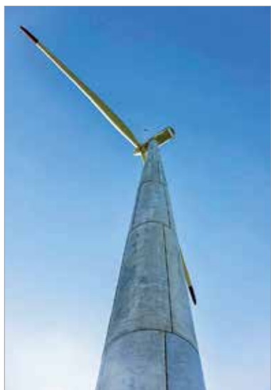
► Figura 2 Torre eólica composta por segmentos de concreto pré-fabricado grauteados in loco
