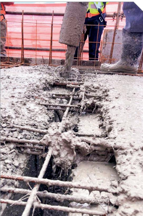
Lançamento do concreto reforçado com fibras no sistema construtivo de paredes de concreto
