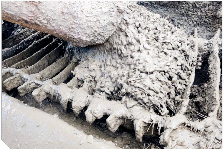
Aspecto do concreto reforçado com fibras no momento de seu lançamento
