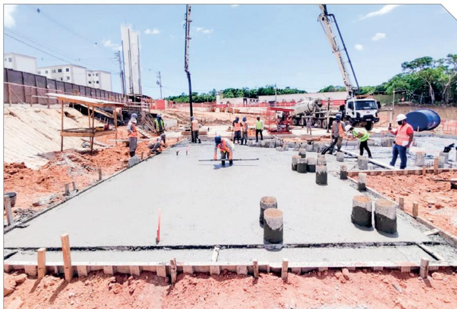
Radier sendo executado com concreto reforçado com fibras
