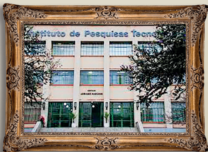
Fachada do Edifício Adriano Marchini no Instituto de Pesquisa Tecnológicas de São Paulo
